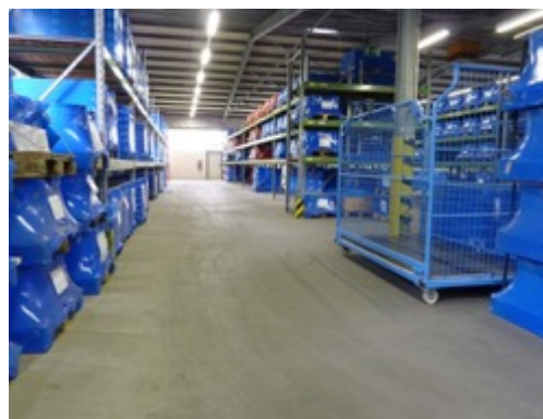
Abbildung 8: Instandsetzung (links) und Fertigstellung (rechts) einer gerissenen Lagerfläche mit DucoPlan (d = 3 cm)
