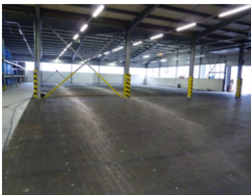
Abbildung 8: Instandsetzung (links) und Fertigstellung (rechts) einer gerissenen Lagerfläche mit DucoPlan (d = 3 cm)
