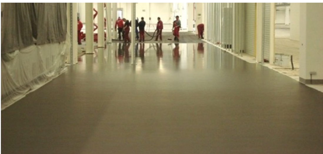
Abbildung 4: Mörtelinfiltration (oben) und fertiggestellte Fläche im Innenbereich (unten)
