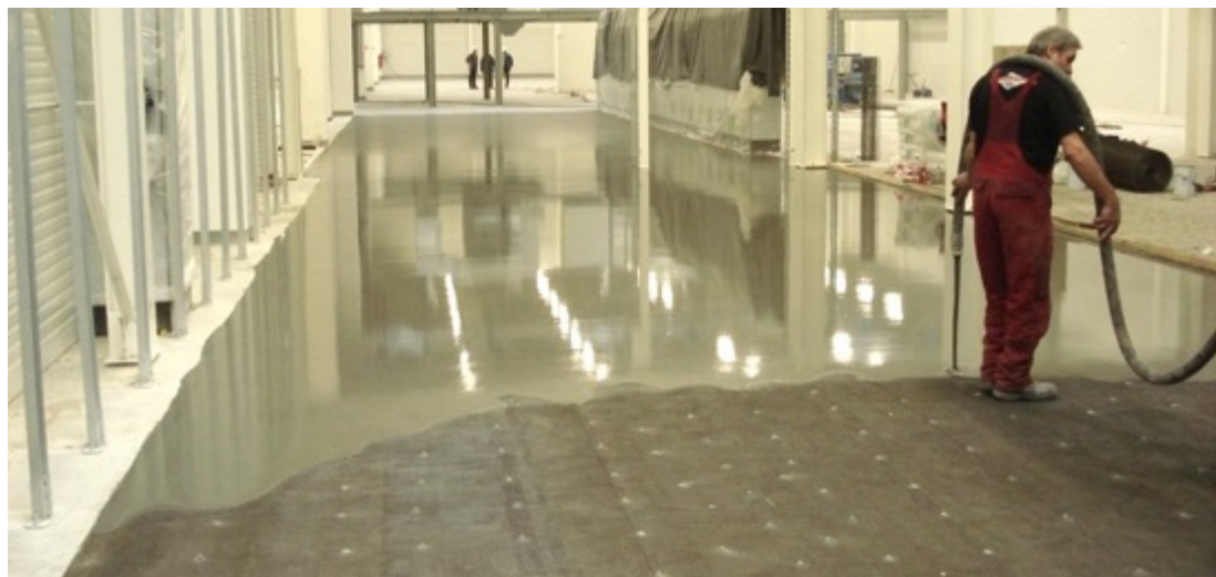
Abbildung 3: Mörtelinfiltration (links) und fertiggestellte Außenfläche (rechts)
