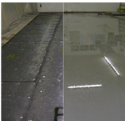
Abbildung 6: Montage MicroMat® und Mörtelinfiltration (links); Belastung einer DUCON Fläche 2 Tage nach Herstellung durch eine Druckmaschine (rechts)
