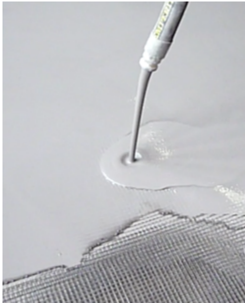
Abbildung 3: Mörtelinfiltration (links) und fertiggestellte Außenfläche (rechts)
