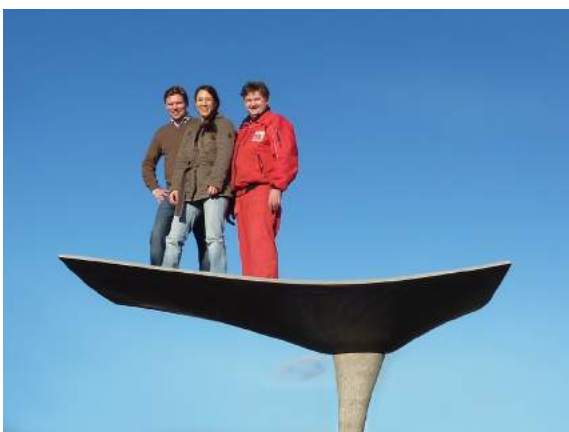
Bild: "Parapluie" d= 25 – 30mm = dünnste Dachschaale
