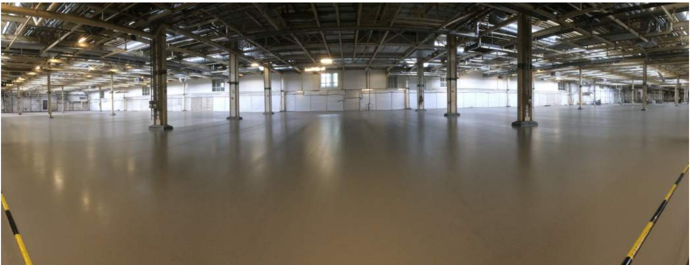
Bild: WHG-Dichtschicht und Tragschicht d=55mm, 15.500m 2 fugenlos, Automobilindustrie
