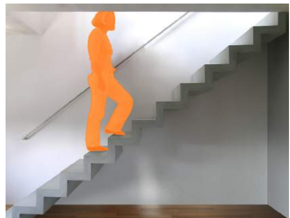
Bild: Freitragende Faltwerkterrasse d=80mm = dünnste Betontreppe
