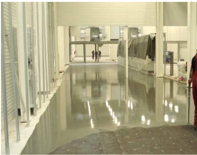
Bild: Herstellung der Deckenverstärkung d=60mm)
