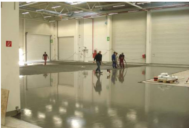
Bild: Betonage mit DUCON1-Beton
