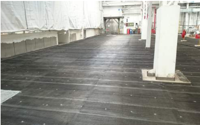
Bild: Verlegung der Mikroarmierung MicroMat®
