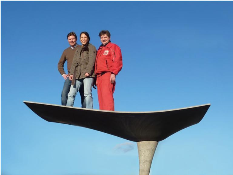
Bild 4: „Parapluie“ – ultradünne Dachschale ( $d = 3\text{ cm}$ )
