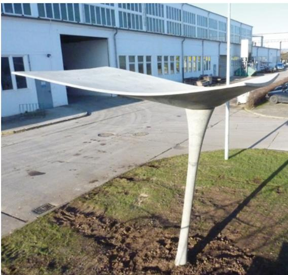
Bild 5: Exzentrische Dachschale, Stütze mit Entwässerung
