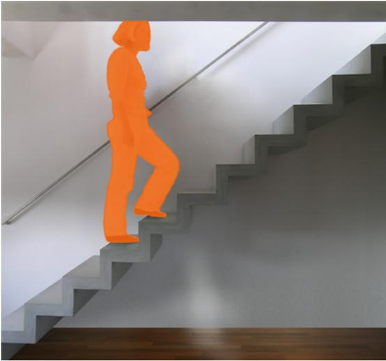
Bild 7: Freitragende Faltwerktreppe (d = 8 cm)
