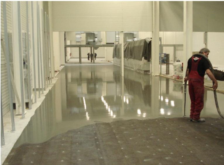
Bild 26: Betoninfiltration in Mikroarmierung
