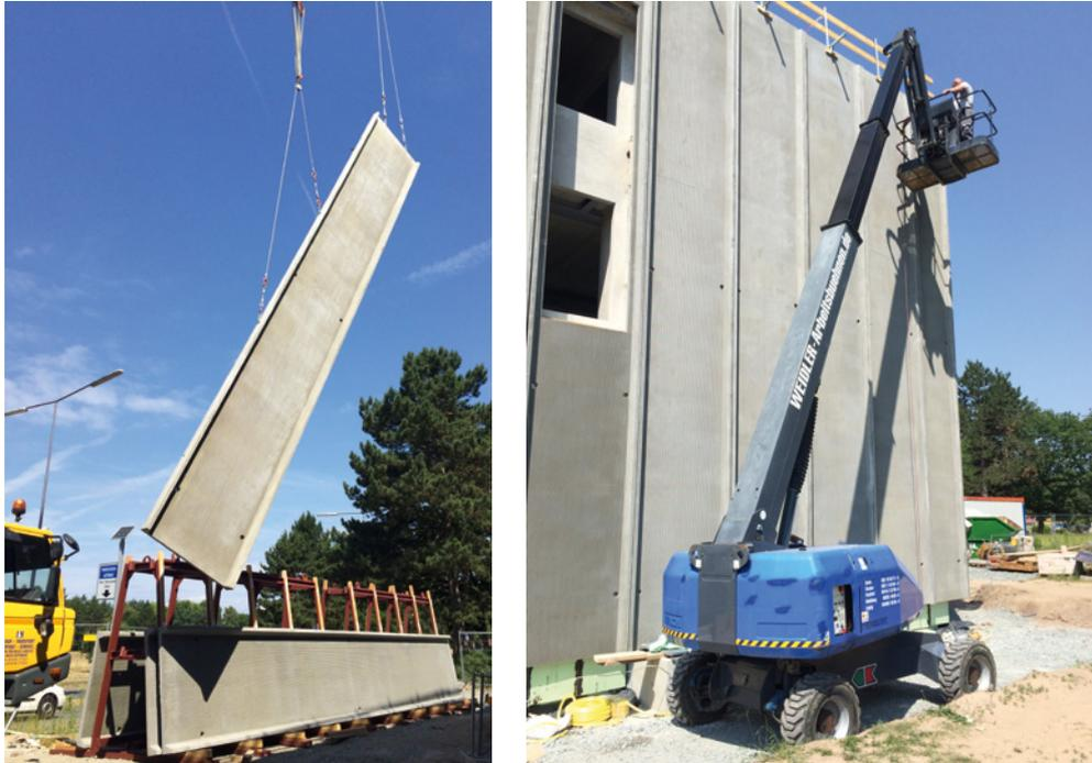
Bild 31: Montage Fassadenplatten
