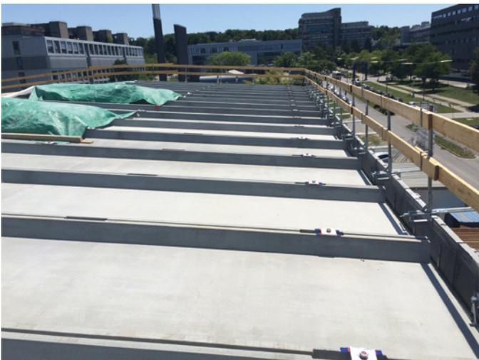
Bild 34: Tragende Dachplatten (l=10,6 m, d=5,5 cm) als Kühlplatten
