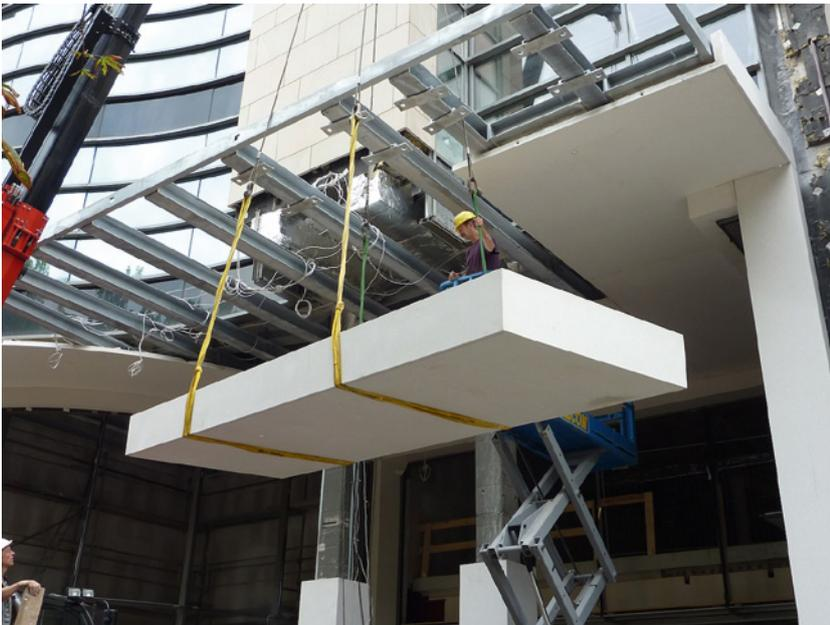
Bild 16: Montage abgehängte Platte mit Aufkantung (l = 7,5 m, d = 7 cm)
