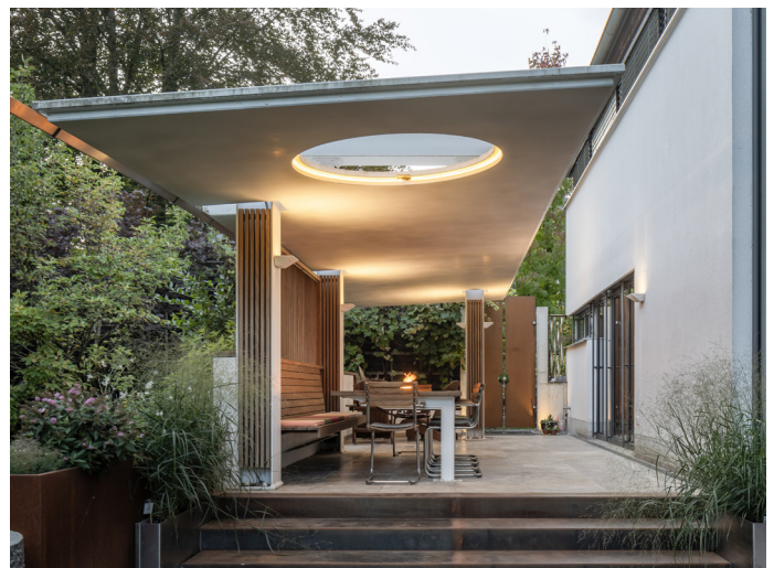
Filigrane Dachplatte (11 m lang, 80 mm dünn), Bad Griesbach
