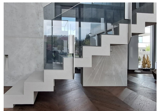
Faltwerkterre mit Glasgelder
