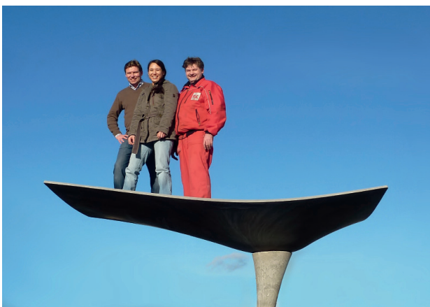
„Parapluie“ – ultradünne Dachschale (d=30 mm)
