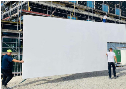
Großformatige und gleichzeitig ultra-dünne Bauweise (55 mm bei 20 m 2 )
