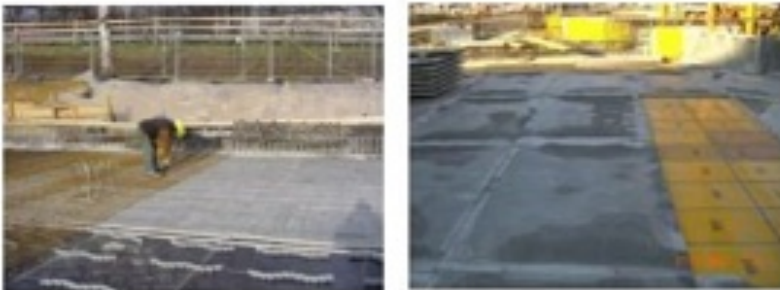
Şekil 10: Döküntü koruma tabakasının uygulanması
