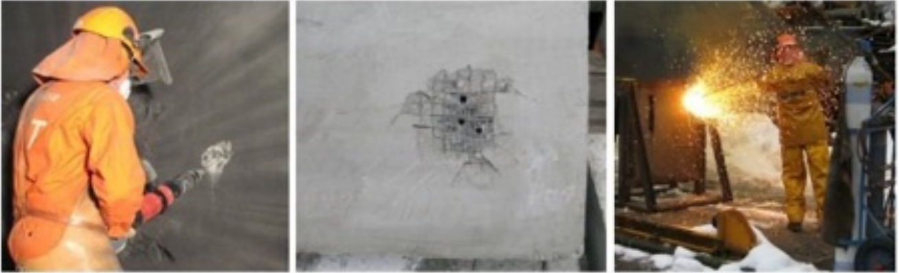
Şekil 4: Bileşen kalınlığı: 10 cm: Kaya matkabı ile (solda); çoklu ısıli direkt yangın ile (ortada) delme girişimi; oksijen üfleme borusu ile delme girişimi (sağda)
