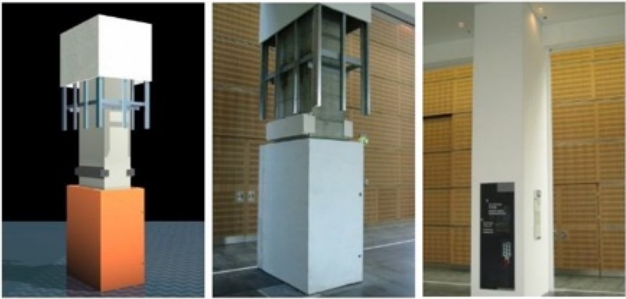
Şekil 7: Kolon takviyesi: konsept (sol), uygulama (orta), Son durum (sağ)
