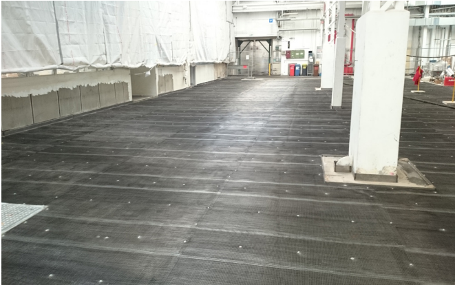
Bild: Verlegung der Mikroarmierung MicroMat®
