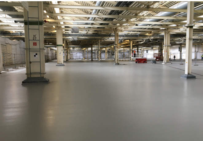
Bild: Fertiggestellte Fläche
