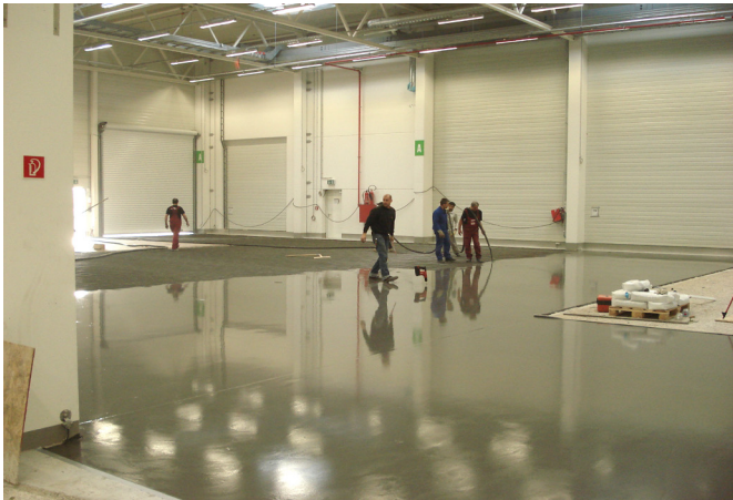
Bild: Betonage mit DUCON1-Beton
