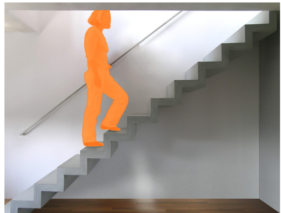
Bild: Freitragende Faltwerktreppe d=80mm = dünnste Betontreppe
