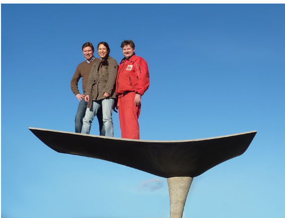
Bild: "Parapluie" d= 25 – 30mm = dünnste Dachschaale
