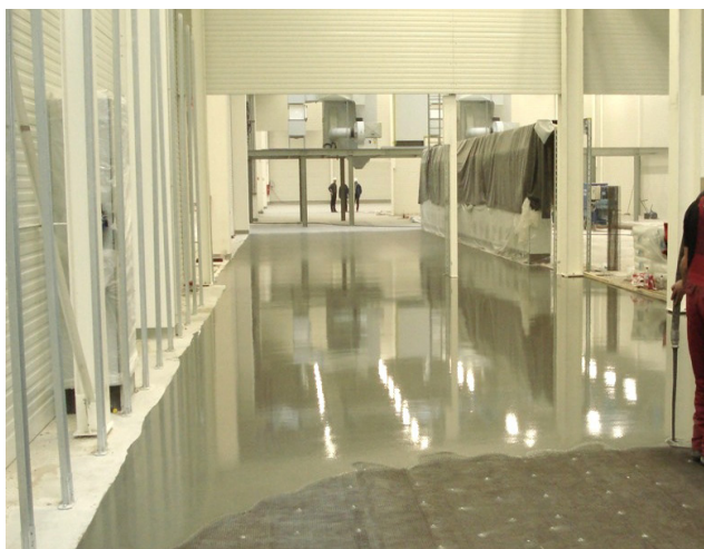
Bild: Herstellung der Deckenverstärkung d=60mm)
