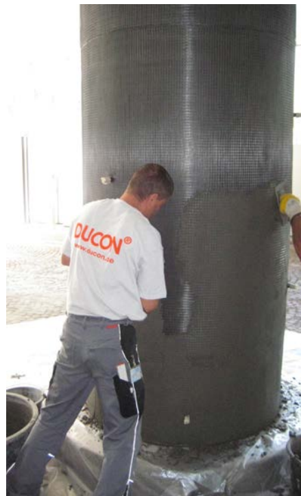
Bild: Stützenverstärkung für Explosions-, Anprall- und Erdbebenschutz
