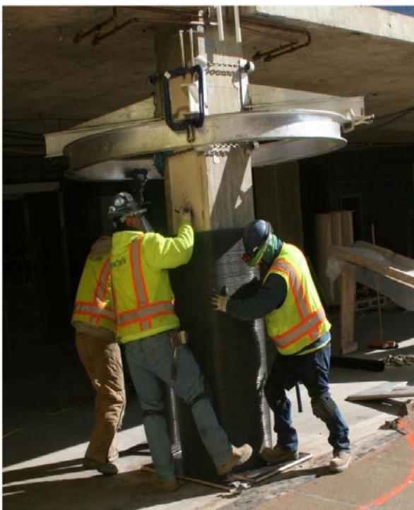
Bild: Stützenverstärkung für Explosions-, Anprall- und Erdbebenschutz
