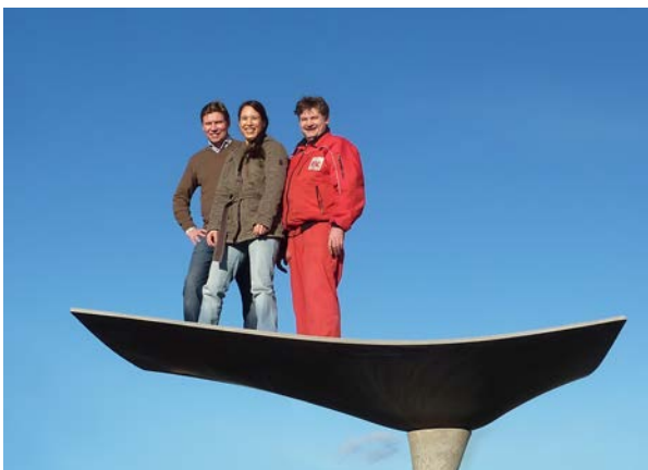
Bild: "Parapluie" d = 25 – 30mm = dünnste Dachschale
