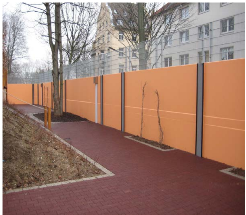
Schutzwand gefährdete Einrichtung, Deutschland
