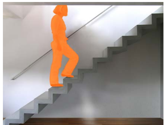
Bild: Freitragende Faltwerkterruppe d=80mm = dünnste Betontreppe
