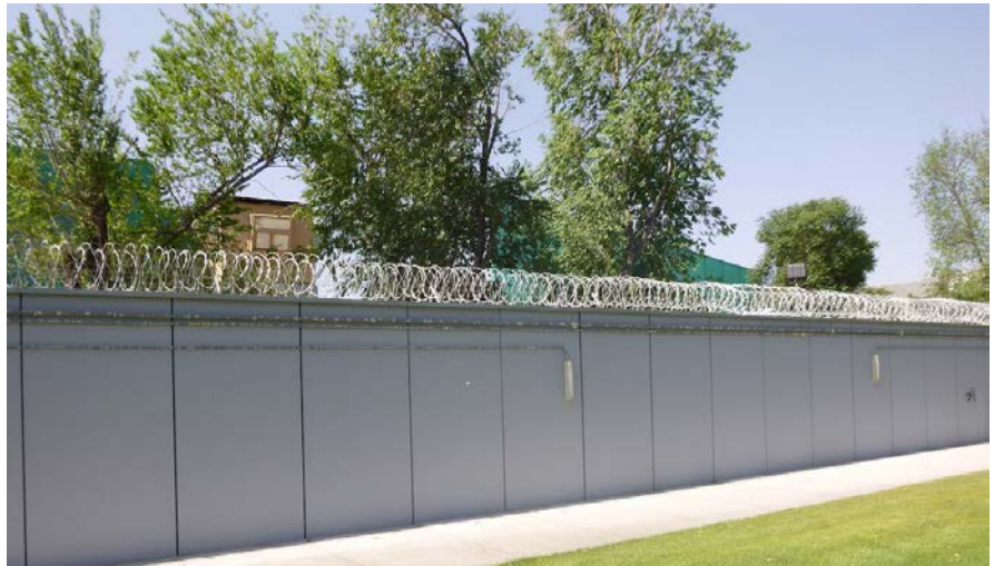
Bild: Schutzwand gegen Explosion, Schutzmauer von deutschen Botschaften
