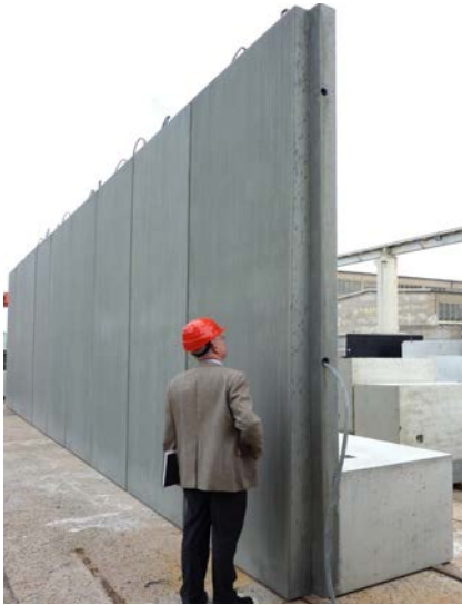
Bild: Schutzwand gegen Explosion, Schutzmauer von deutschen Botschaften
