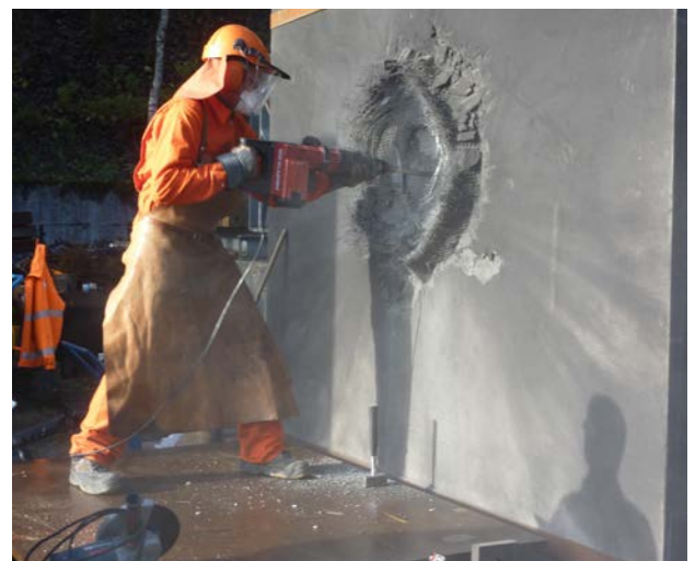
Durchbruchversuch nach Anspannung
